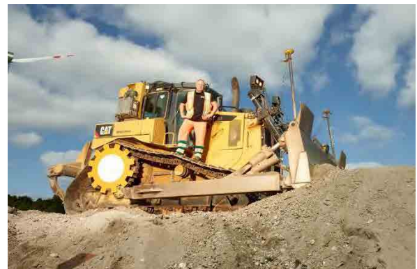
Abbildung: Kettenraupe auf der Deponie
