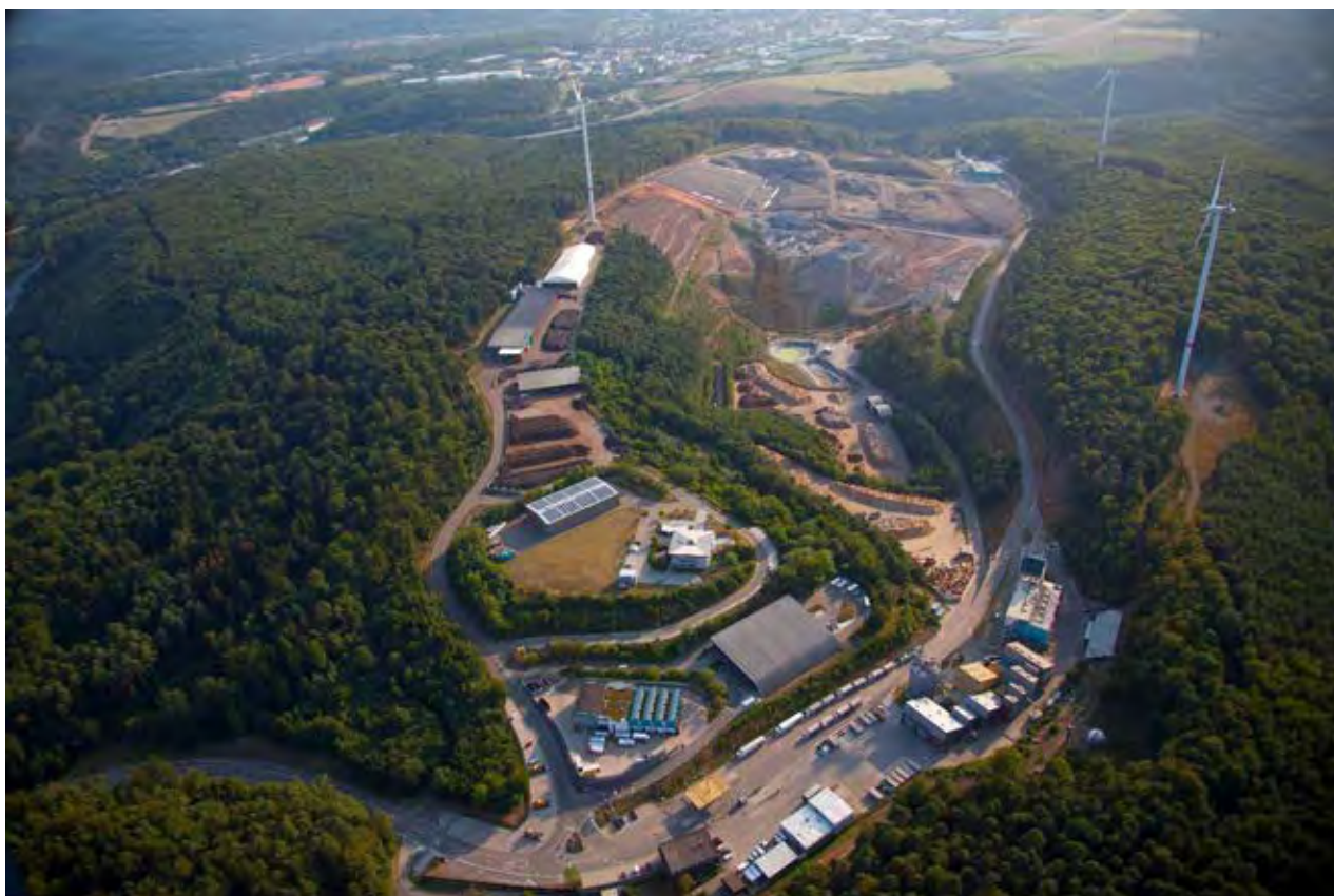
Abbildung: Luftbildaufnahme Abfallwirtschaftszentrum Kaiserslautern-Mehlingen
